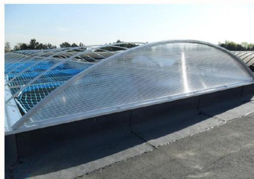
Fig 7 Panneau intérieur et arceau inférieur du tympan posés
