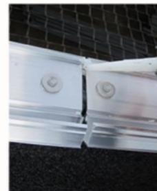
Fig 5 Obturez le joint du profilé longitudinal
