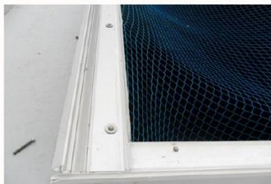
Fig 3 Fixation du profilé longitudinal
