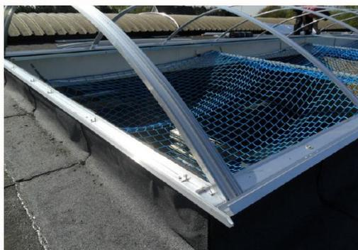
Fig 6 Arceau inférieur du tympan monté
