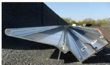
Fig 2 Positionnez le premier profilé longitudinal à côté de la costière (voir schéma de pose)
